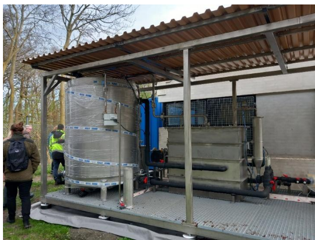
Figure 3 - L'unité de méthanisation de Bornholm (projet SYMSITES), située à la station d'épuration
