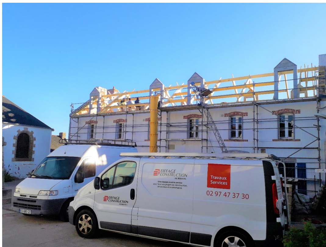
HOUAT : Travaux d'économies d'énergie à la mairie
