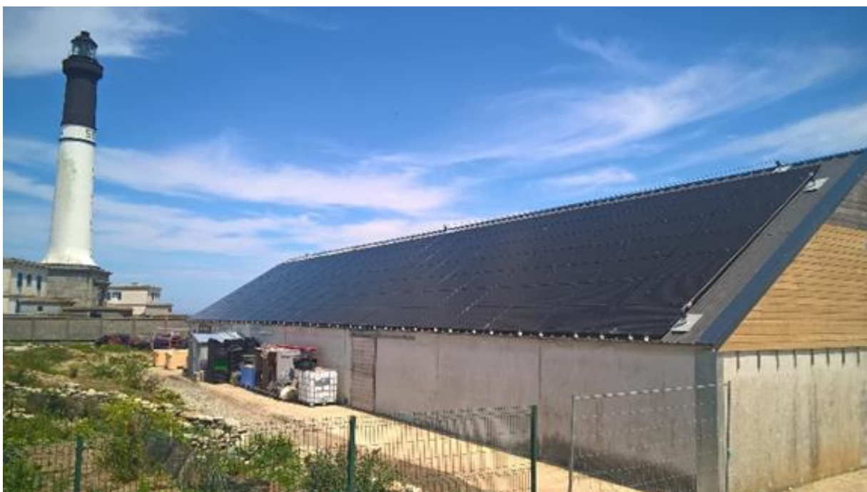
SEIN : Installation photovoltaïque sur l'écloserie
