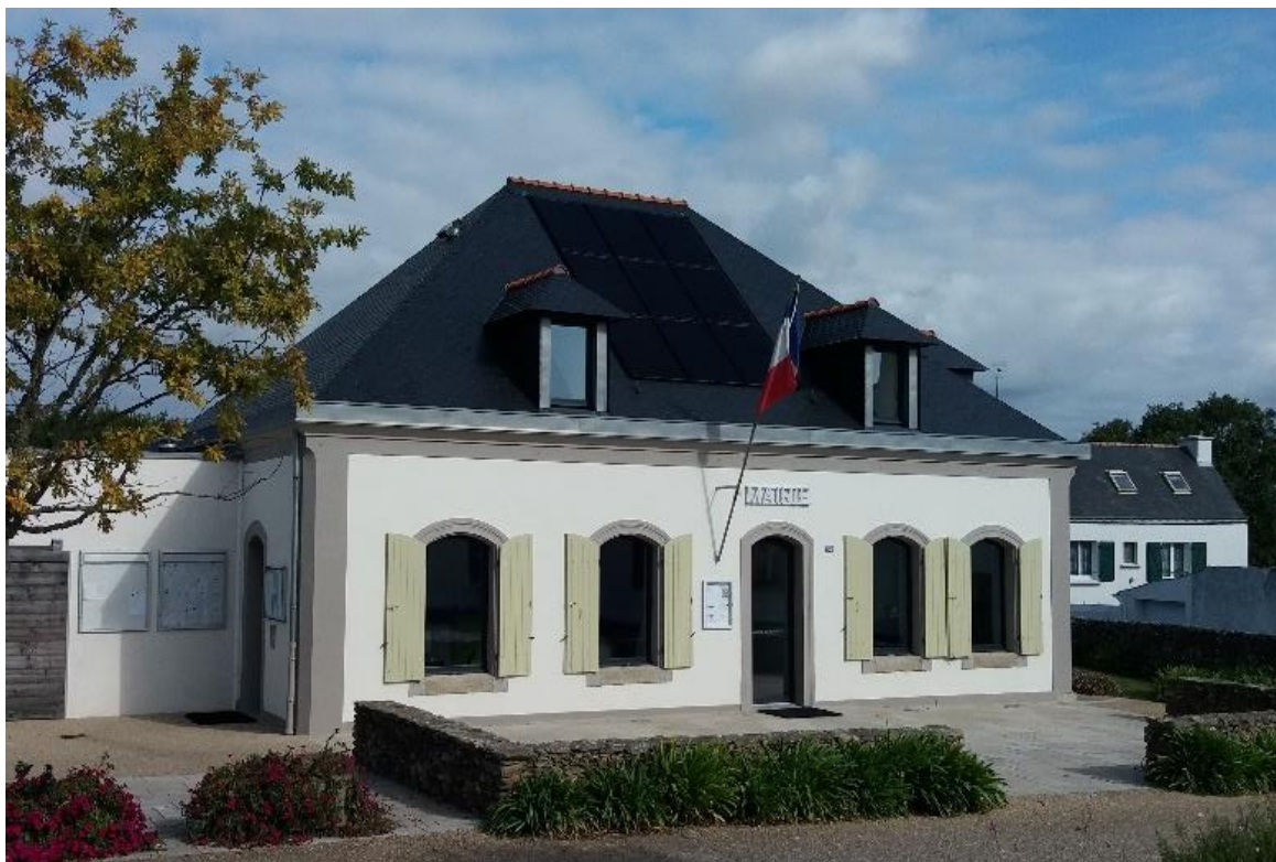
BELLE-ILE-EN-MER : Installation photovoltaïque sur la mairie de Bangor
