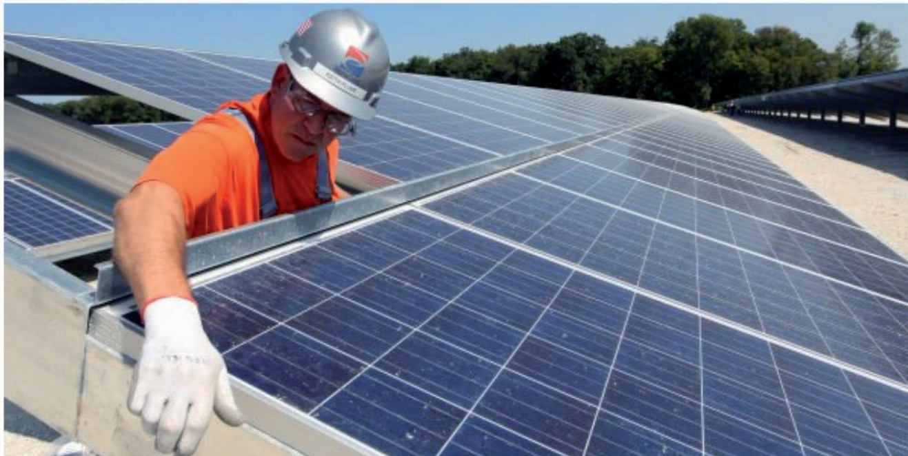
© MaxPPP | Les trois îles prévoient l'installation de panneaux photovoltaïques et d'éoliennes.
