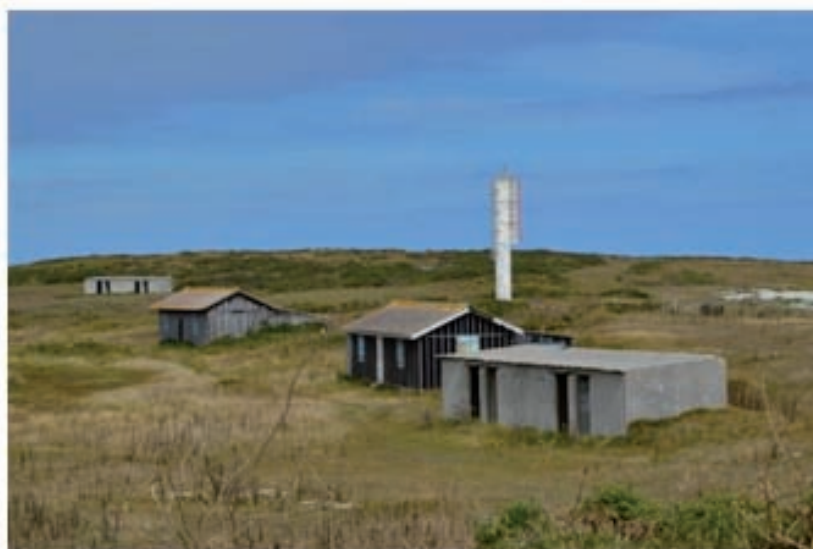
L'îlot Ledenez Vras, juste en face de Molène, sur laquelle les cabanes de goémoniers seront réhabilitées et équipées de panneaux photovoltaïques. Photo : MEG/EB
