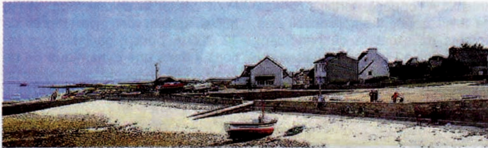
À Molène, des panneaux photovoltaïques seront placés sur la centrale EDF.
